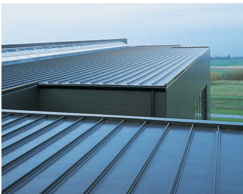
Aluminium-Bördelfalz-Eindeckung
