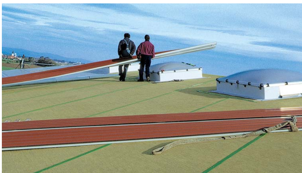
Verlegung der Metalleindeckung auf dem Prodach-Dämmsystem
