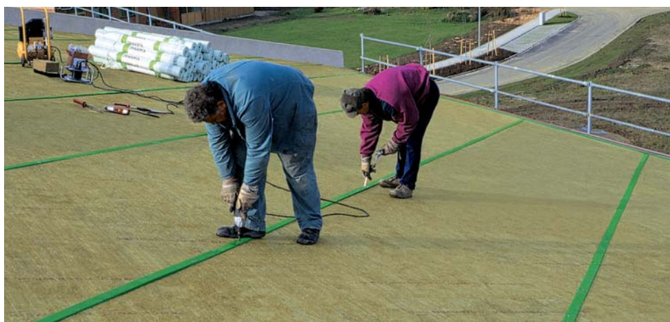
Montage der Prodach-Befestigungsschienen
