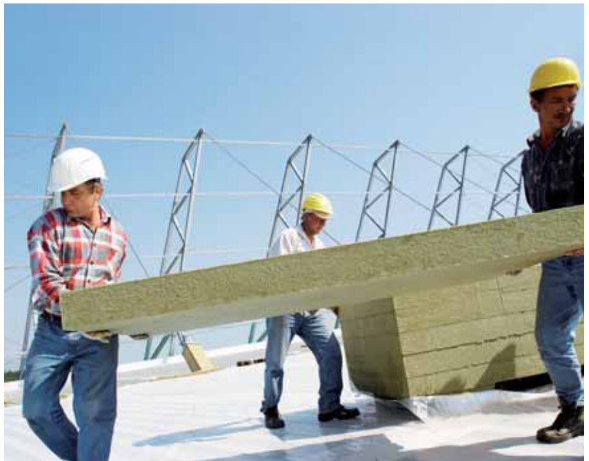
Verlegung der Durock Großformatplatten
