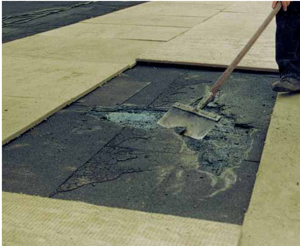
Lose Bestandteile werden zunächst von der alten Dachfläche entfernt
