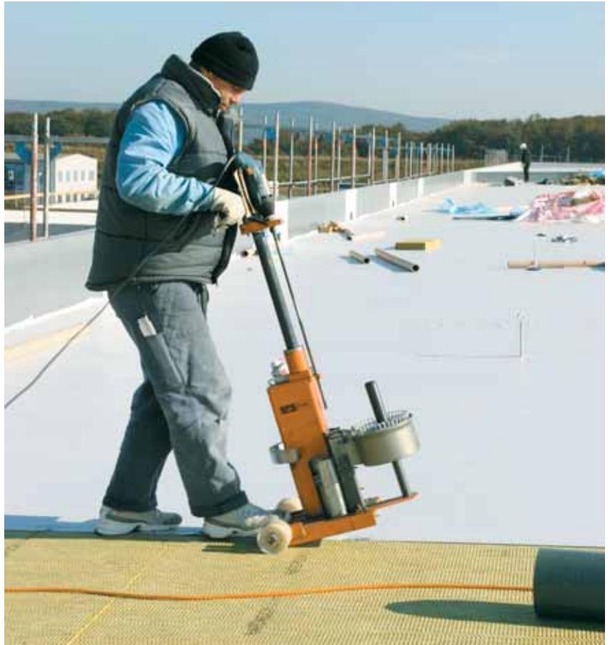
Mechanische Befestigung der Abdichtung auf Durock 037
