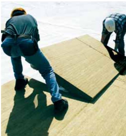
Die schnelle Verlegung der Großformatplatten sorgt für Kostenvorteile
