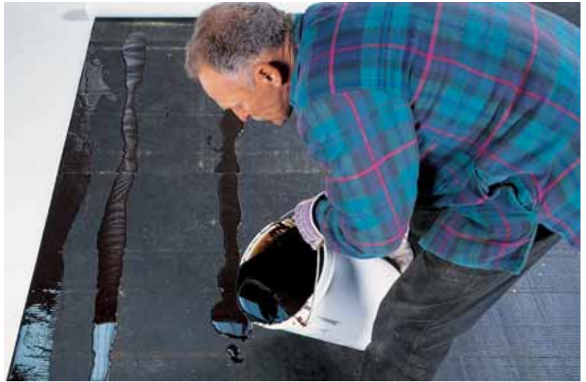
Kaltverklebung der Dachabdichtung auf der Bondrock
