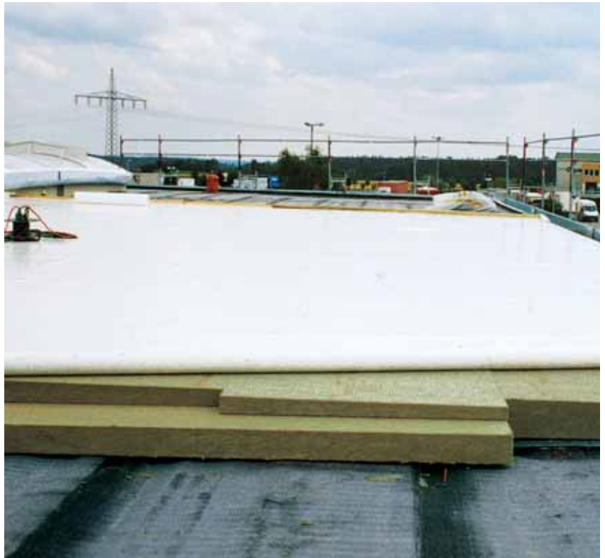
Verlegung des Gefälledachs Georock auf der Grunddämmung
