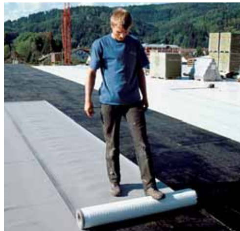
Dachaufbau verklebt
