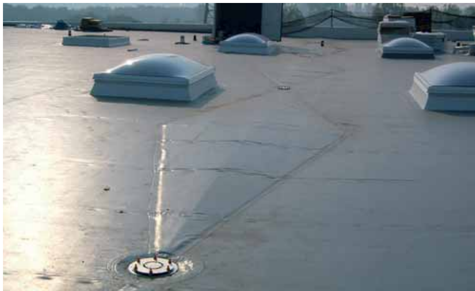
Punktentwässerung entlang der Kehllinien
