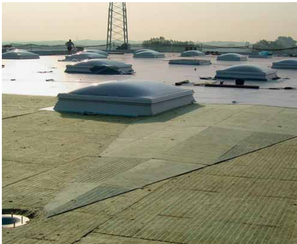
Verlegung der Kehlgefälleplatten Keprock
