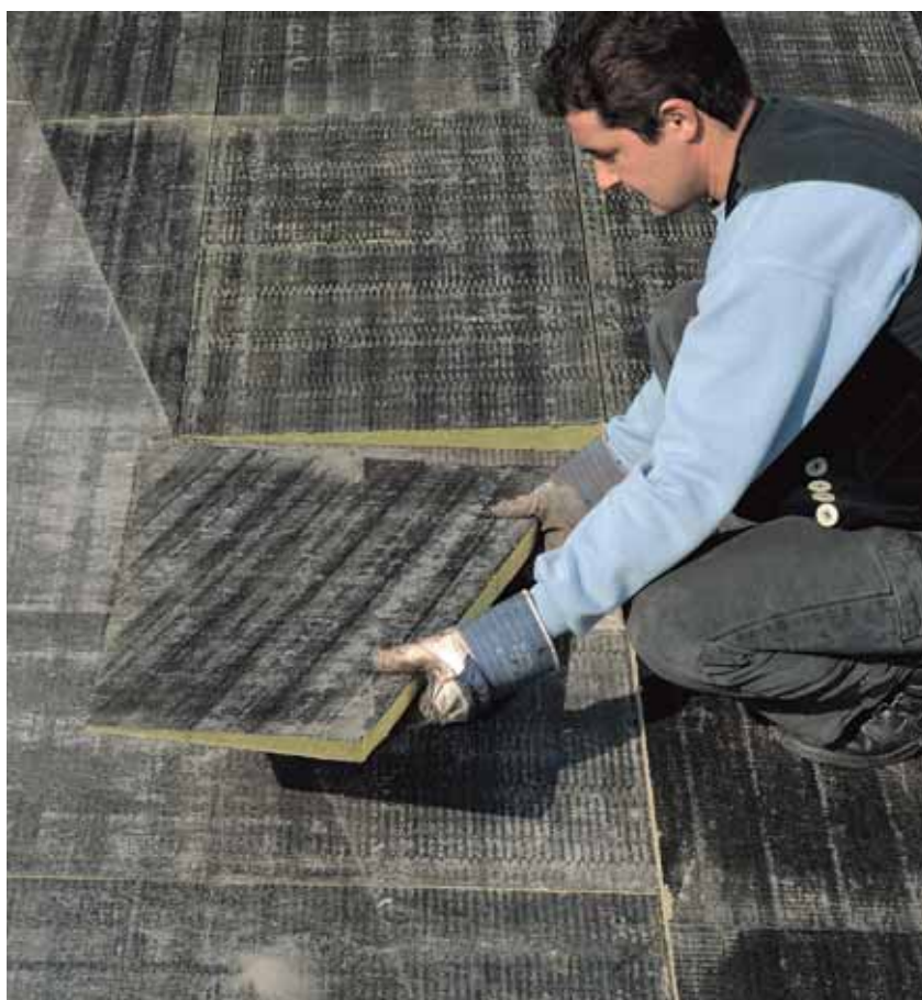
Verlegung der Kehlgefälleplatten Keprock Plus
