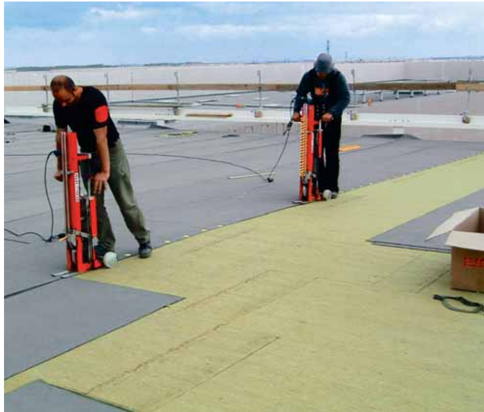
Dachaufbau mechanisch befestigt
