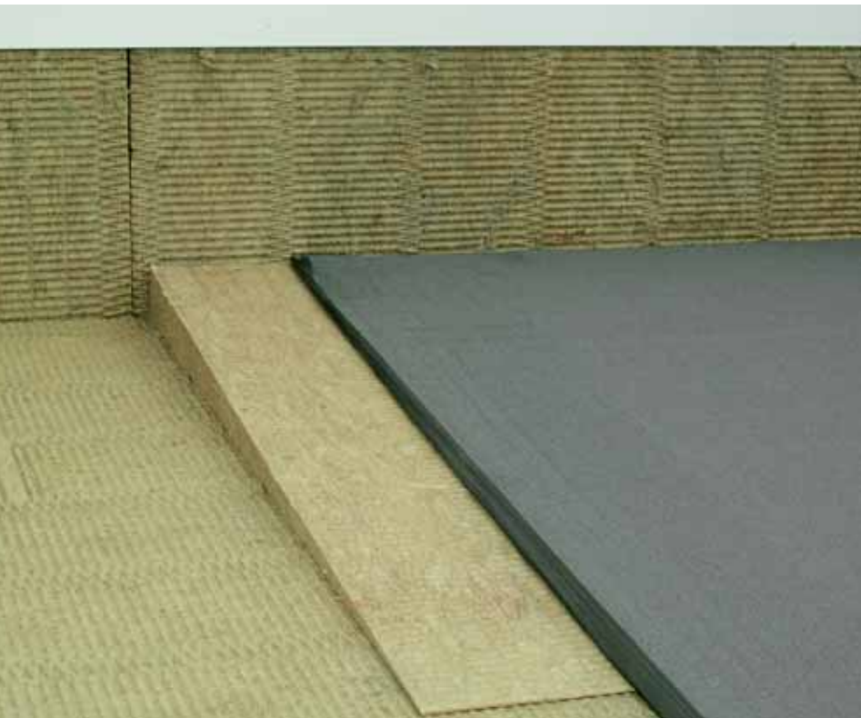
Attikabereich mit Kontergefälledachplatten RP-KGD
