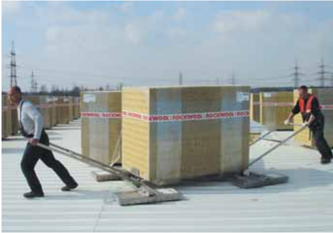
Transport der Großgebinde mit dem Lift and Roller
