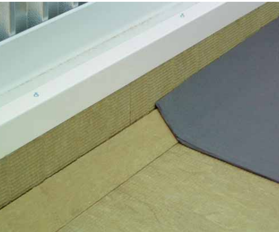
Attikabereich mit Dachkeilen RDK
