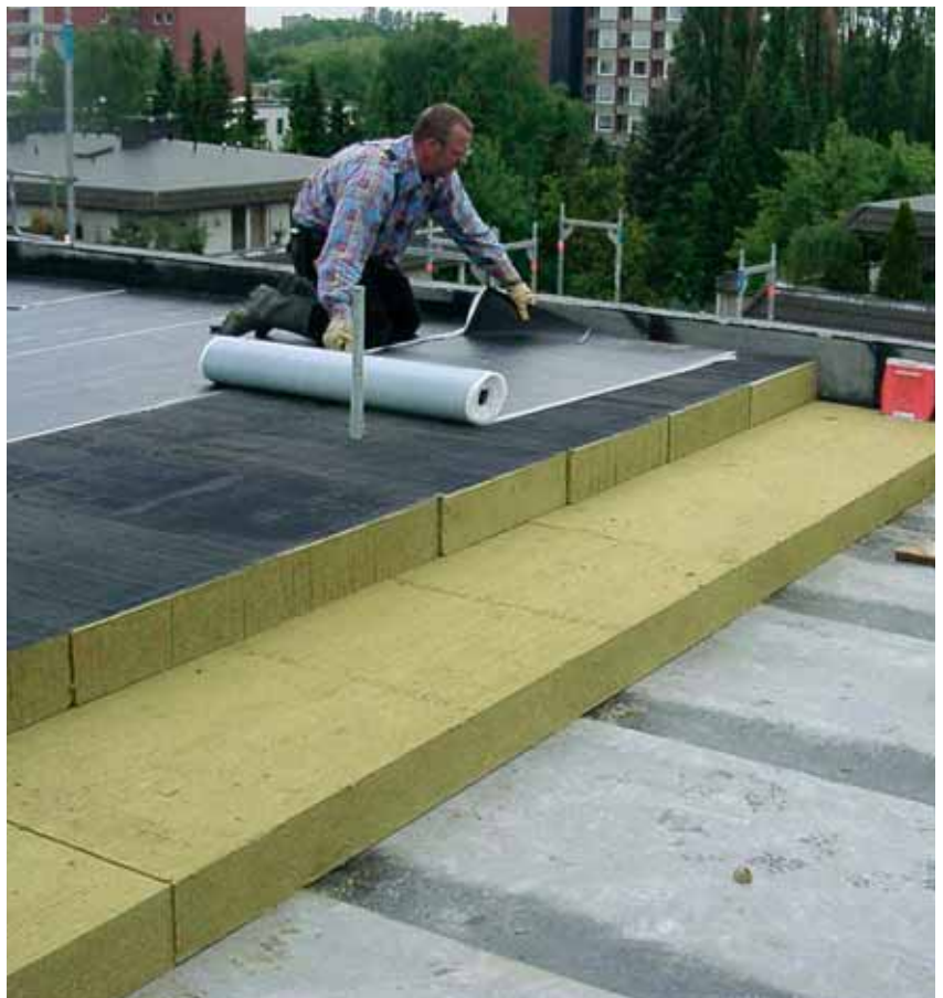
Verlegung des Gefälledachs Georock Plus
