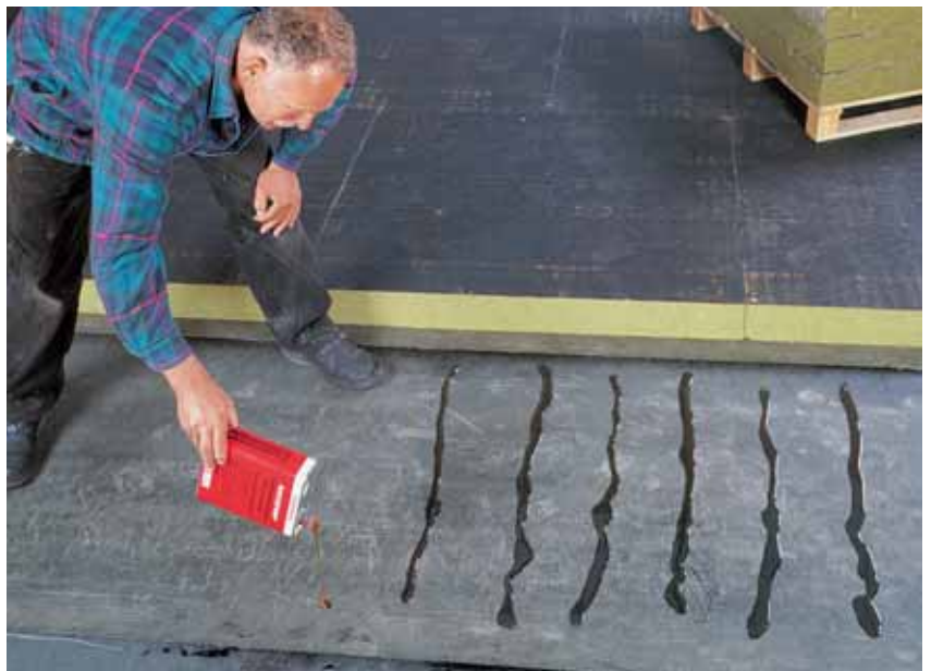
Rockpur wird streifenförmig auf die Dampfsperre aufgetragen
