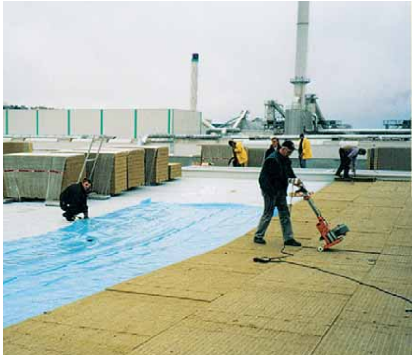
Verlegung der Dachabdichtung auf Durock
