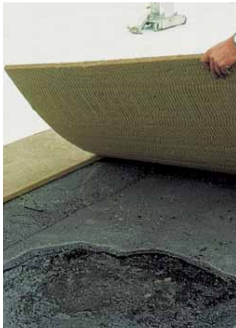
Verlegung der RP-TF auf ausgebessertem alten Dachaufbau
