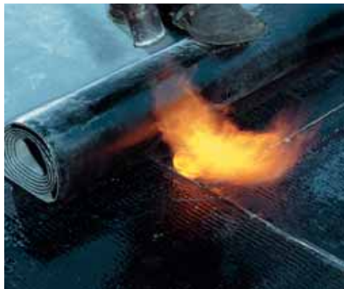
Heißverklebung der Dachabdichtung auf der Bondrock
