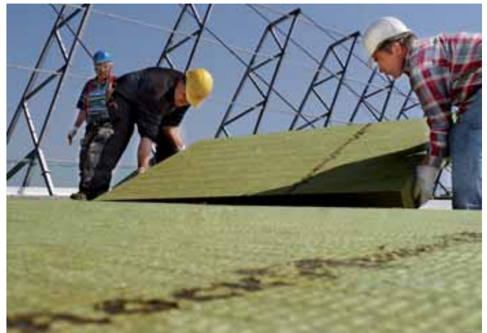
Die Verlegung der Dämmplatten erfolgt im Verband
