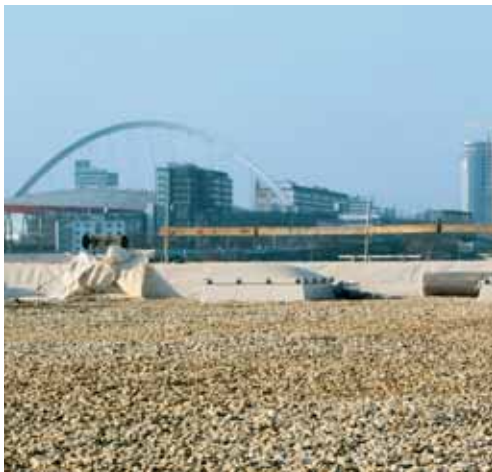
Dachaufbau mit Auflast
