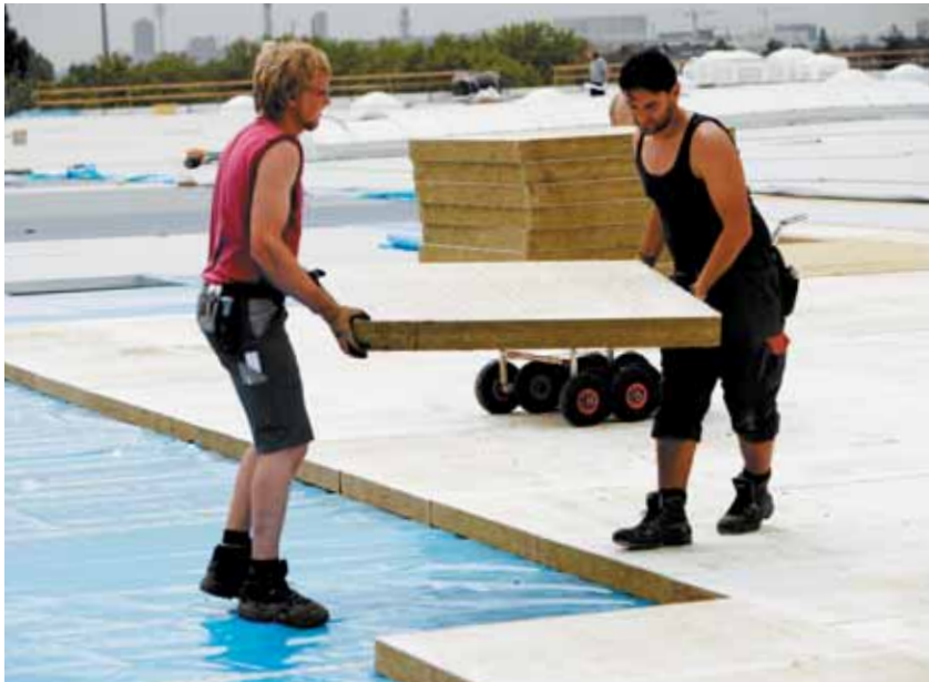
Verlegung der Megarock
